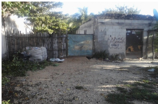
Figura 6: Vista de viviendas donde se acopia en jumbos el pet.
